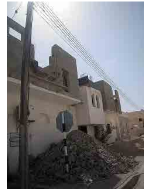
図 4-15 架空低圧電線 (DPC 設備)
