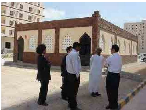
(a) 地上設置型(1 MVA×5 台)
