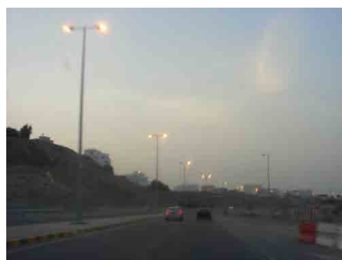
マスカット郊外の高速道路
