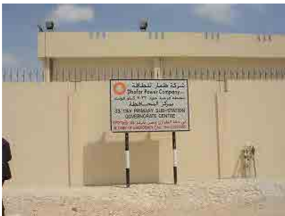
(a) 一次変電所外観
