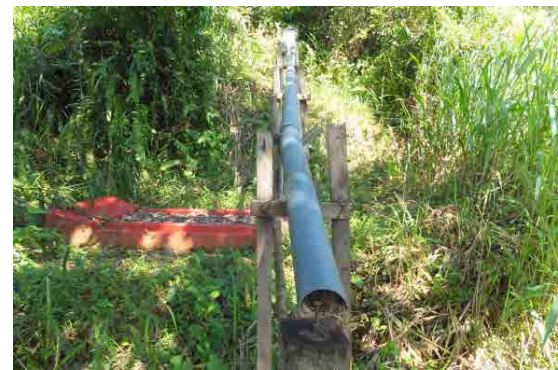
写真 6 地すべり斜面に設置された伸縮計
