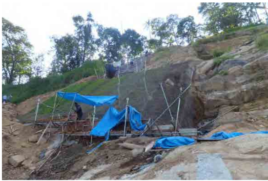
写真7 対策工施工状況
