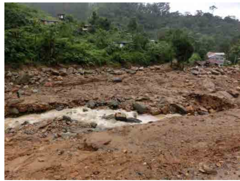
写真8 土石流発生箇所
