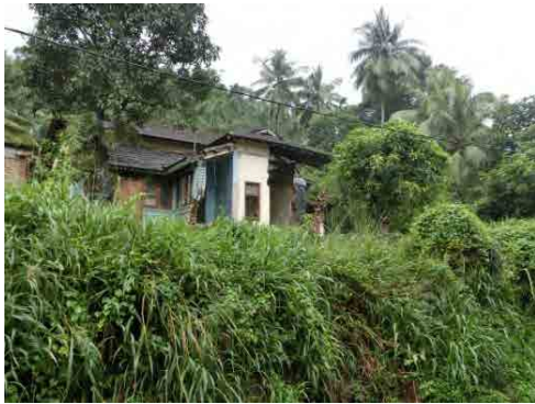
写真9 地すべりで半壊した家屋
