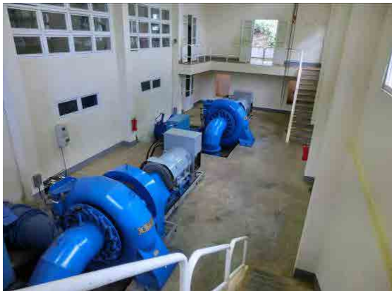
(10)オチュム第二発電所：水車・発電機全体図 手前が 2 号機、奥側が 1 号機。3 交代の一人勤務および日勤者が 4 名で発電に当たっている。
