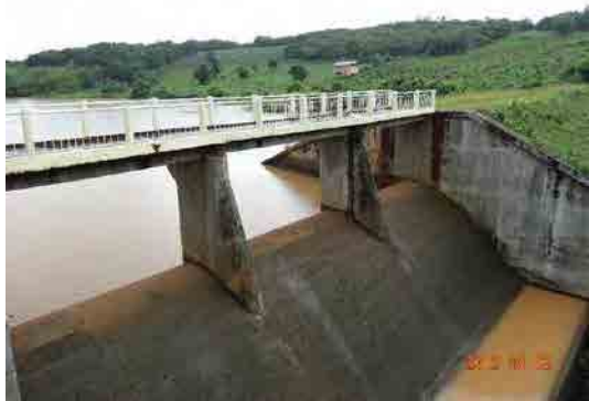
(8)オチュム第二ダム洪水吐き：約 20 年経過しているものの、土木構造物の健全度に問題はない。
