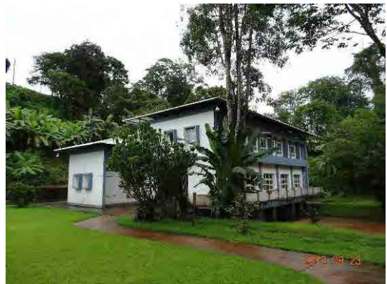
(9)オチュム第二発電所建屋：設備出力 960kW であるが機器の劣化が進み 820kW の発電しか出来ない。
