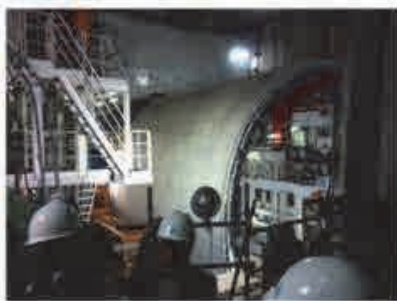
横浜環状線シールド・トンネル（2010.11）
