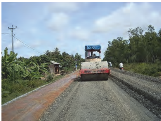
パイロットプロジェクト視察 (カンダール州国道110号線)
