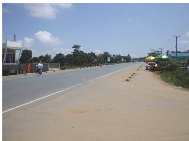
国道1号線（カンダール州）視察
