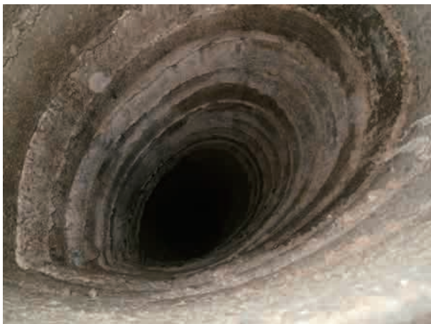
カナートの立坑
