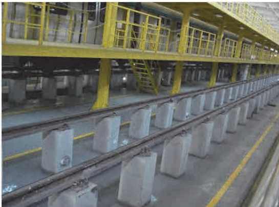
Nguồn: Đoàn nghiên cứu chụp Hình 3.5.3 Đường kiểm tra bảo dưỡng
