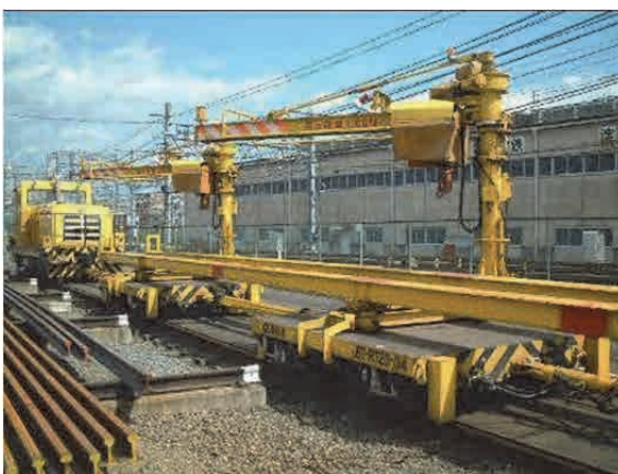
Nguồn: Đoàn nghiên cứu chụp Hình 3.5.13 Ray- tàu vận chuyển bê tông dự ứng lực PC
