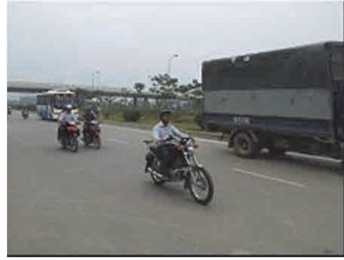
Nguồn: Đoàn nghiên cứu chụp Hình 3.1.25 Khu vực dự kiến đặt ga số 6 (gần vị trí 6k600m)
