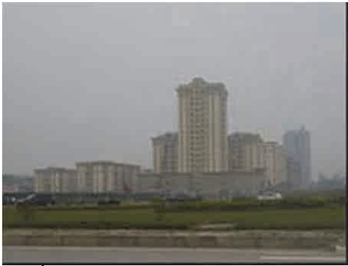
Nguồn: Đoàn nghiên cứu chụp Hình 3.1.26 Khu vực dự kiến đặt ga số 6 (gần vị trí 6k600m)
