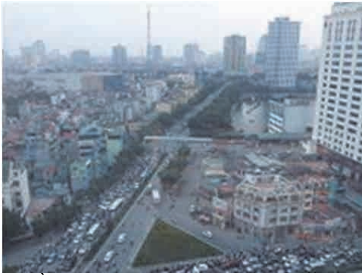
Nguồn: Đoàn nghiên cứu chụp Hình 3.1.9 Giao cắt với Tuyến số 3 (gần vị trí 1k400m)
