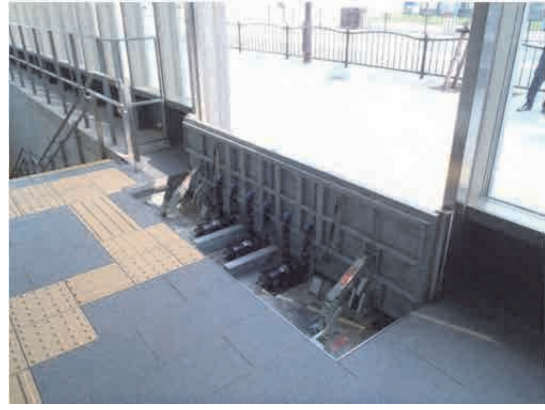
Hình 3.4.35 Ví dụ đặt tấm ngăn chống nước
