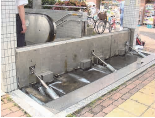
Hình 3.4.35 Ví dụ đặt tấm ngăn chống nước
