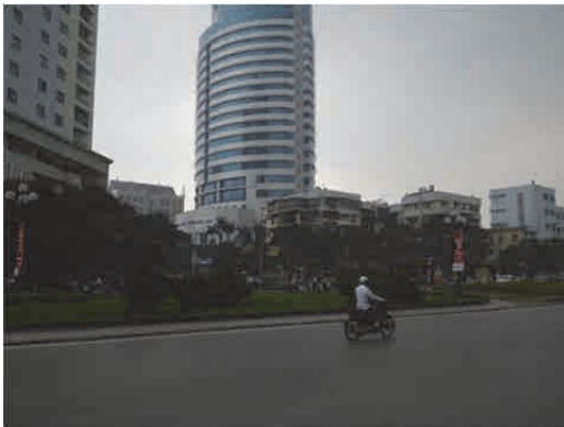
Nguồn: Đoàn nghiên cứu chụp Hình 3.1.20 Khu vực dự kiến đặt ga số 4 (gần vị trí 3k900m)
