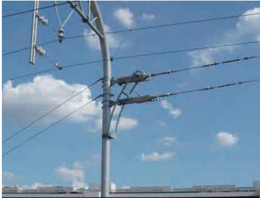
図 3.6.9 自動張力調整装置の概観図
