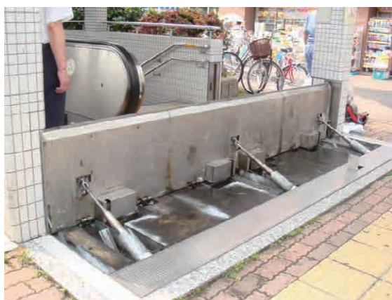
図 3.4.35 止水板設置事例
