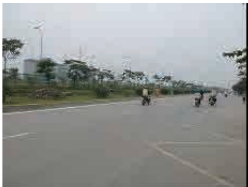
出典：調査団撮影 図 3. 1. 24 St. 6 計画付近 (6k600m 付近)
