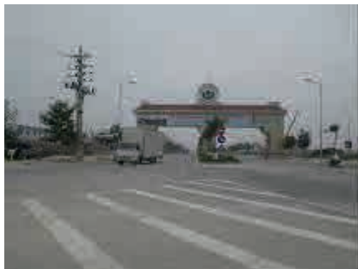
出典：調査団撮影 図 3.1.32 St. 9 付近の開発状況 (南側) (11k800m 付近)
