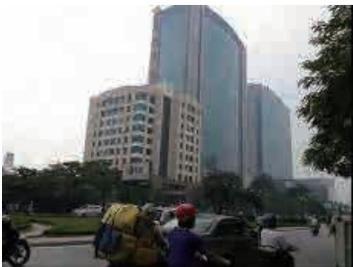
出典：調査団撮影 図 3.1.22 St. 5 計画付近 (4k600m 付近)
