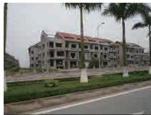
出典：調査団撮影 図 3.1.33 St. 9 付近の開発状況 (南側) (11k800m 付近)
