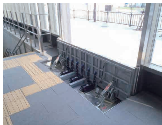
図 3.4.35 止水板設置事例
