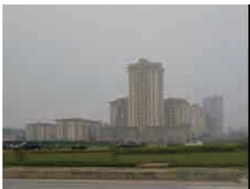
出典：調査団撮影 図 3. 1. 26 St. 6 計画付近 (6k600m 付近)
