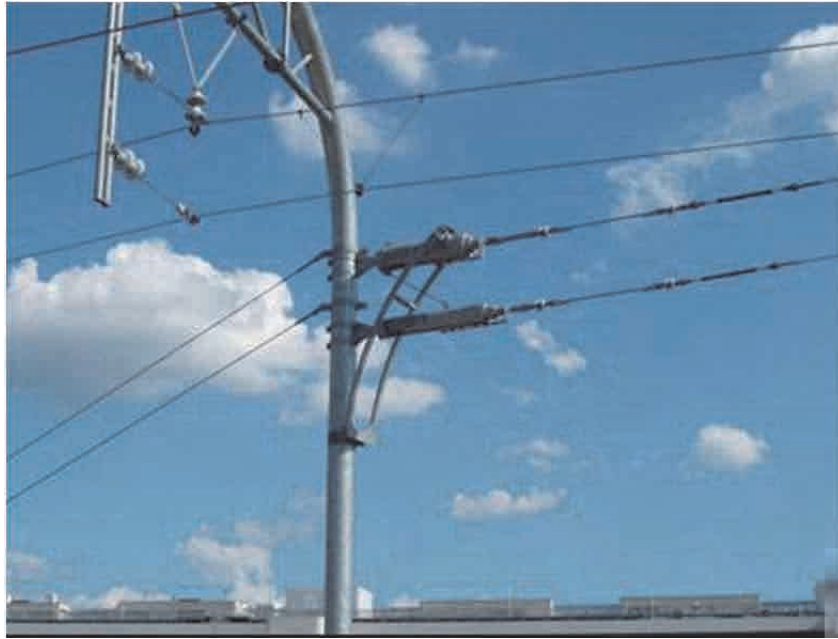
図 3.6.9 自動張力調整装置の概観図
