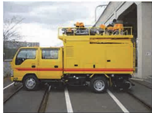
出典：調査団撮影 図 3.5.15 架線検測車
