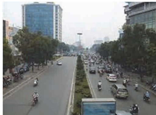
図 3.1.14 中央分離帯が狭い箇所の 道路構成
