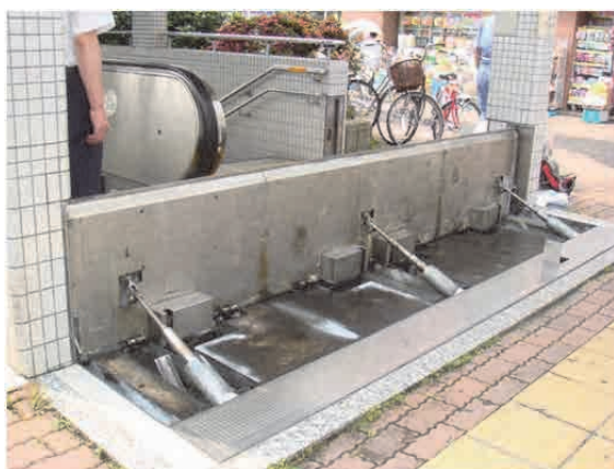
図 3.4.35 止水板設置事例
