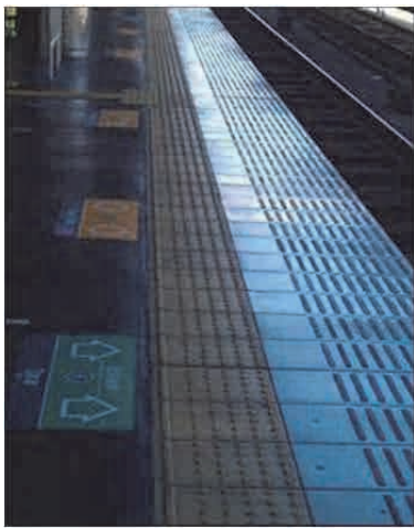
出典：調査団撮影 図 3.4.31 ホーム点字ブロック
