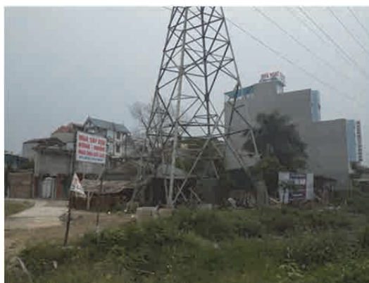
出典：調査団撮影 図 3. 1. 29 St7 より起点方 1km 付近 (7k400m 付近)
