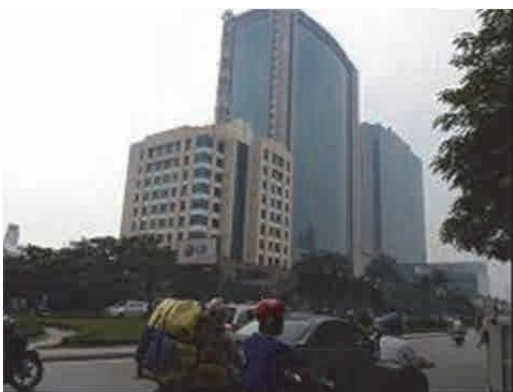
出典：調査団撮影 図 3.1.22 St. 5 計画付近 (4k600m 付近)
