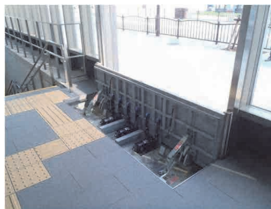
図 3.4.35 止水板設置事例
