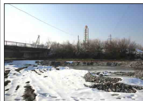
⑥ Насыпь на правом берегу Кок-Арт в направлении вверх по течению
