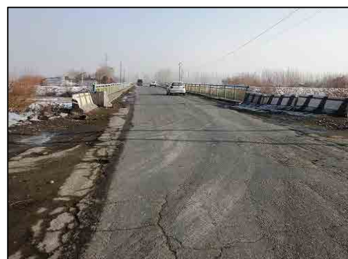
⑫ Автодорога Бишкек-Ош (→исходящий)
