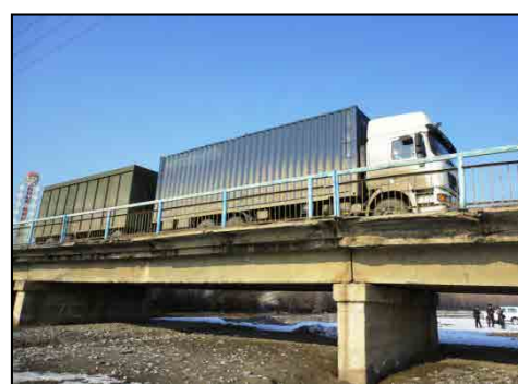
③ Большегрузный автомобильный, проезжающий через мост Кок-Арт
