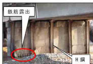
H鋼による補強されている橋脚
