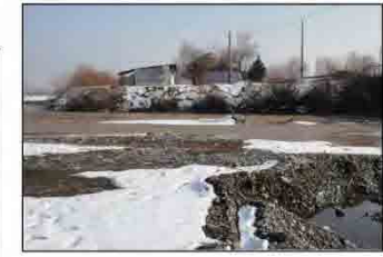
⑪ クガルト川の上流左岸堤防の状況
