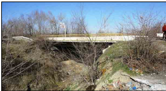
写真 2-2-3 比較的良好的なマディ橋
