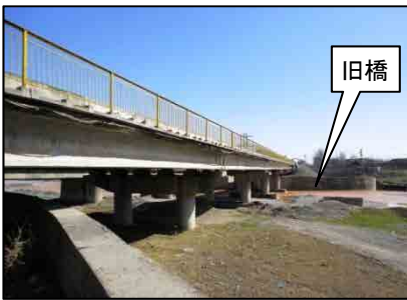
写真 2-2-7 架け替えられたクルシャブ橋
