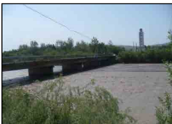
写真 2-2-22 光ケーブルの架空状況
