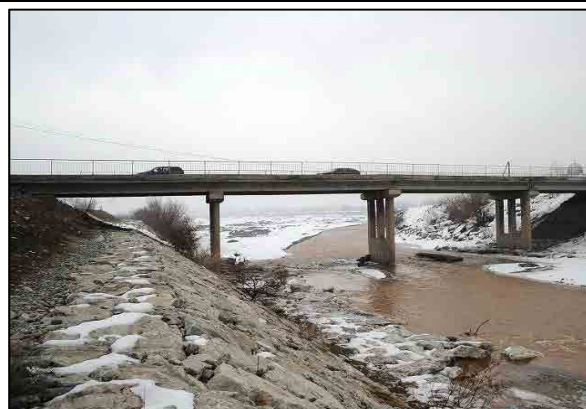
写真-16:クガルト橋の上流に架かるブラゴベシエンカ橋
