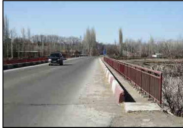
写真 2-2-13 良好な橋面舗装
