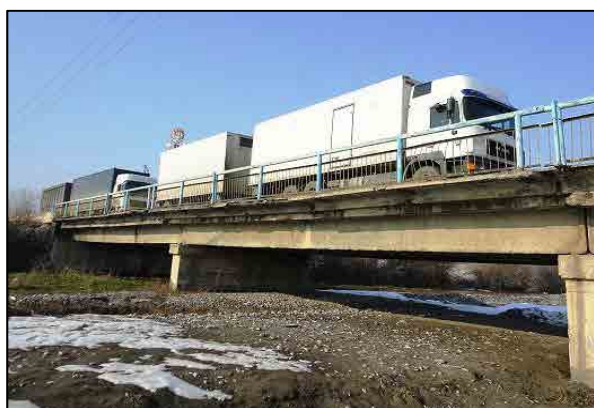
写真-11：頻繁に通行する大型トレーラー
