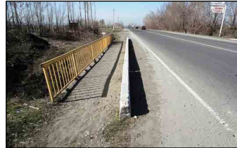
写真 2-2-4 歩道幅員が 1m 以上あるマディ橋
