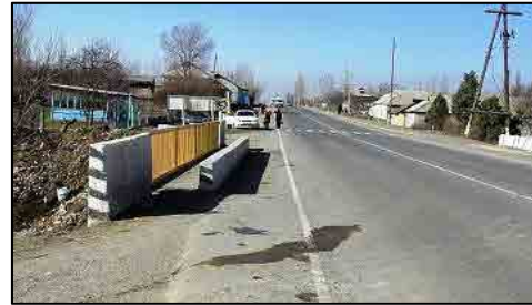
写真 2-2-2 歩道幅員の狭いカールマンサ橋
