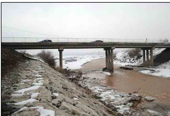
写真 2-2-21 ブラゴベシェンカ橋全景(側面)
