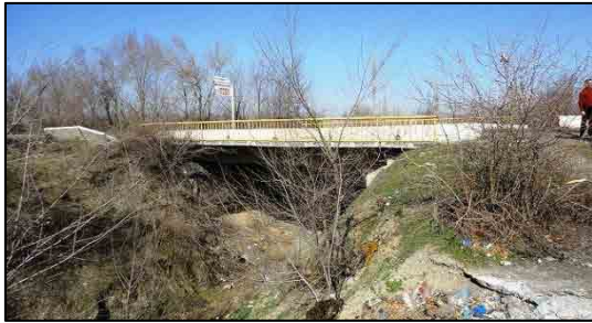
写真 2-2-3 比較的良好的なマディ橋
