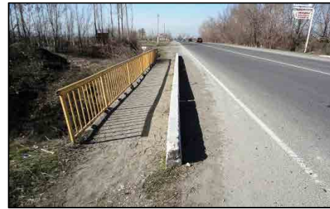
写真 2-2-4 歩道幅員が 1m 以上あるマディ橋
