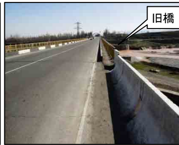
写真 2-2-8 良好な橋面舗装
