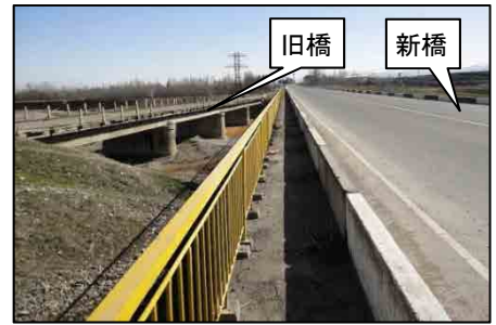
写真 2-2-9 旧橋と並行する新橋
