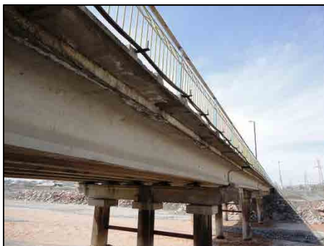
写真 2-2-17 カラウングル橋全景(側面)
