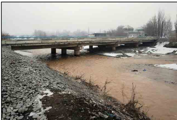
写真 2-2-19 スザク橋全景(側面)
