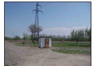
写真 2-2-21 高圧線の敷設状況
