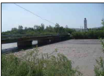
写真 2-2-22 光ケーブルの架空状況
