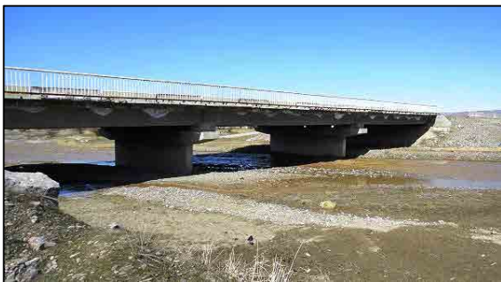
写真 2-2-15 ザルゲル橋全景(側面)
