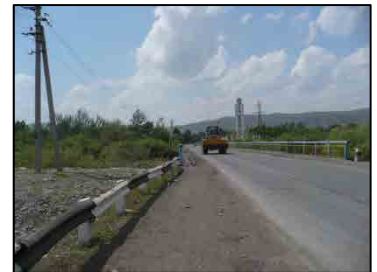
写真 2-2-20 電線の敷設状況
