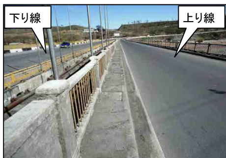
写真 2-2-10 上下線 2 橋のカラダリア橋
