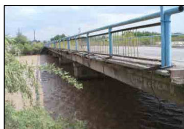
写真 2-2-23 光ケーブルの添架跡
