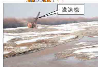
⑨ 堆砂の浚渫状況
