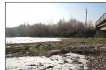
⑭ クガルト川下流の右岸堤防の状況
