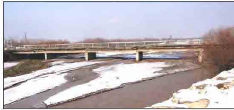
① クガルト橋全景(側面)
