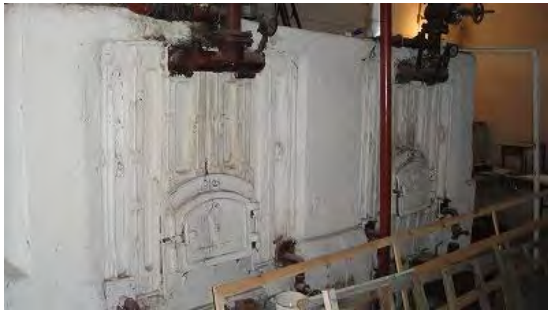
写真-7 : Hincesti 県 Lupusna 村 旧ソ連時代に整備された高校校舎。旧式の石炭ボイラーは燃焼効率が低く現在使用されていない。
