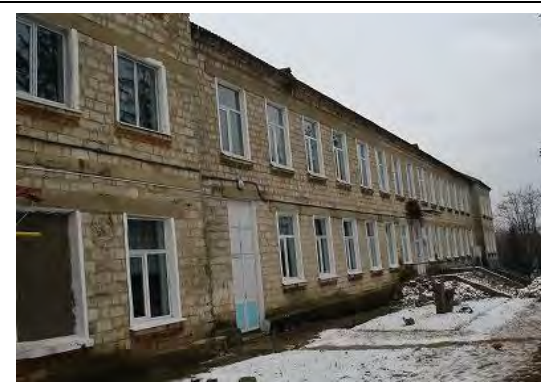
写真-6 : Orhei 県 Piatra 村 小学校校舎の外観。校舎の全ての窓が二重窓に更新されており、保温性が高い。評価も良い施設の一例である。
