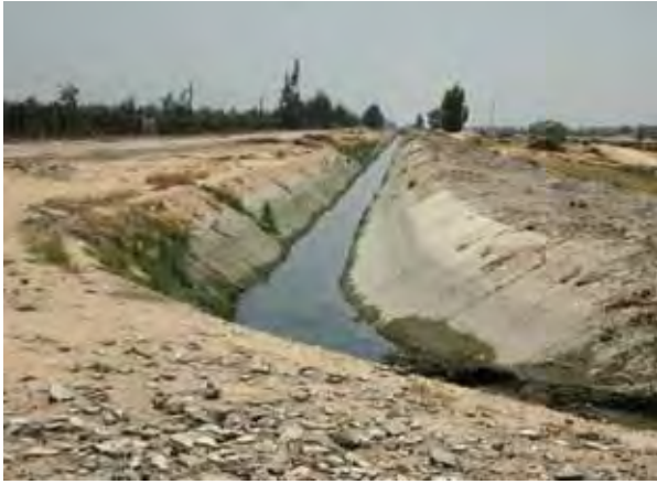
ラシュ・エル・ガルビ支線用水路（下流側）
