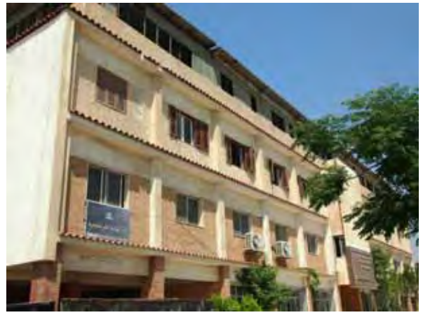
ヌバレーヤ管区灌漑指導部 (GDIAS) の建物
