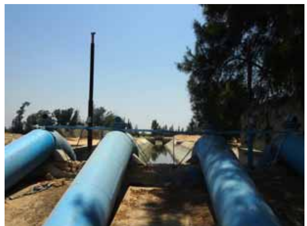
ラシュ・エル・ガルビ支線用水路 (下流側) 取水地点
