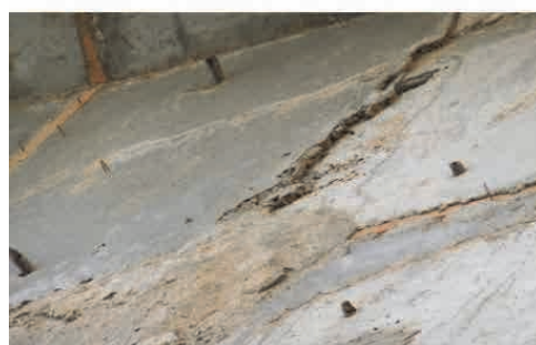
主桁からの遊離石灰
