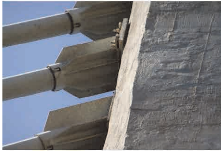
主塔側のケーブル定着部前面
