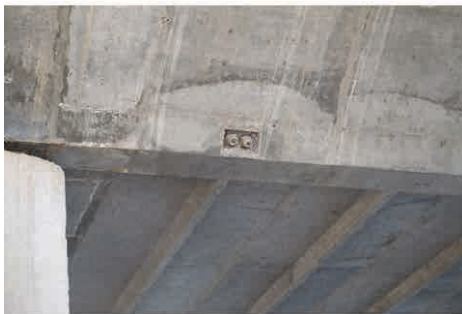
露出された主桁定着部付近
