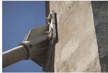
定着版がフィットしていない
