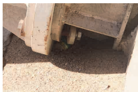
ボルトが緩んだ状態
