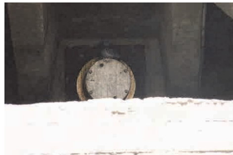
露出された主桁 PC 定着部
