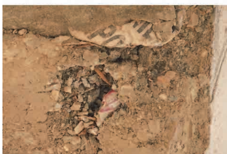
取付高架橋の主桁に不純物混入
