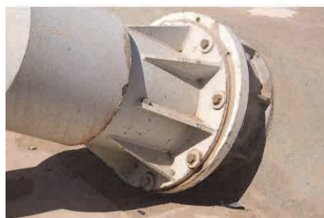
主桁側のケーブル定着部前面
