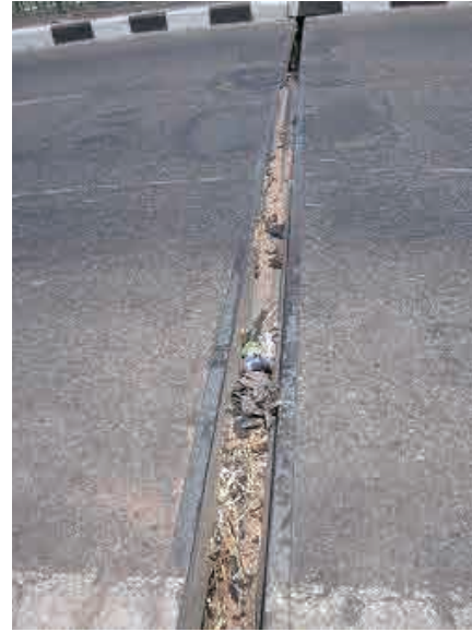
脱落している伸縮装置 (10 th of Ramadan Br.) 大型車両の影響で伸縮装置が脱落している。
