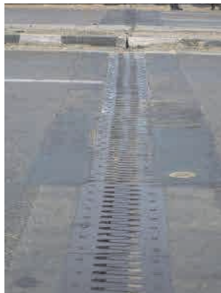
同一方向の車線上であるが、橋脚位置をずらした（橋梁下から見たが橋脚位置をずらす必要があったかは不明）ことにより路面に縦目地が発生しているが、ジョイントは特に設置されていない。
