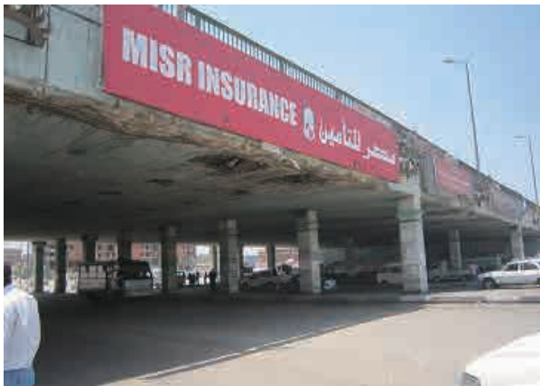
フライオーバー (Al Salam Br.) カイロ市内から北方向へ約 50km 郊外にある Flyover。交差道路のクリアランスが不足している。
