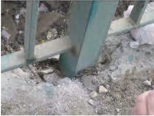
橋梁上の鋼製高欄であるが、支柱部分の施工不良による鉄筋露出が散見されている。
