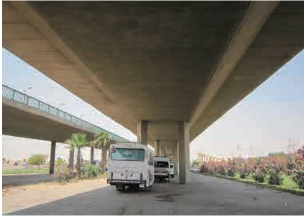
フライオーバー (10 th of Ramadan Br.) フライオーバー高架橋。RCボックス型式で2柱橋脚。外観上は大きな損傷はない。
