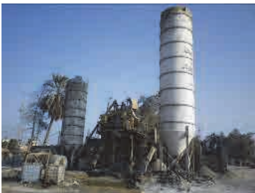
現場にあったコンクリートプラントの設備。かなり古くなっている状態
