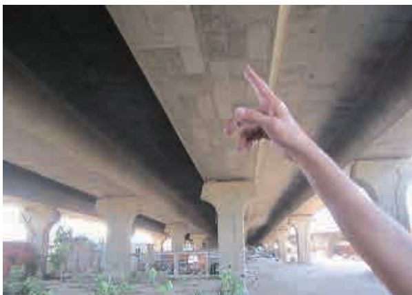
リングロード高架橋 (Al Warag Br.) カイロ市内のリングロード高架橋。開発公社が建設し GARBLT が管理している。形式はコンクリートボックス桁、T 橋脚。
