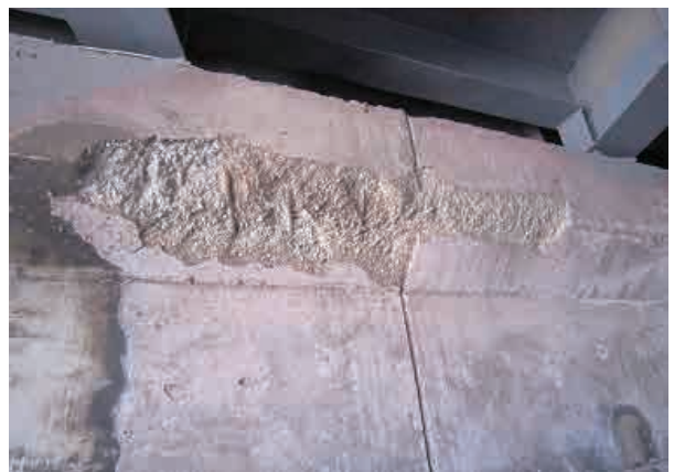
橋脚コンクリート剥離（Basatee Br.）
