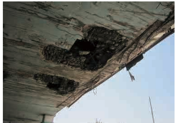
桁下不足により損傷 (Al Salam Br) 高架橋下の交差道路のクリアランス不足のため車両が衝突し桁が損傷している。コンクリートが破損し、鉄筋が露出している。
