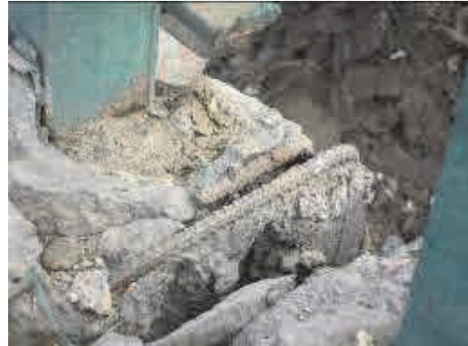
橋梁上の鋼製高欄であるが、支柱部分の施工不良による鉄筋露出が散見されている。
