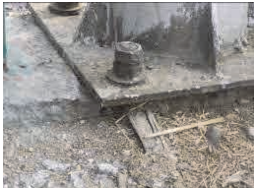
道路照明の基礎部分が施工不良（下に基礎部分のコンクリートがない）により、しっかり固定されていない箇所が多数発見された。
