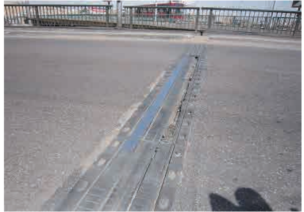
破損している伸縮装置（Otostrad Br.）
