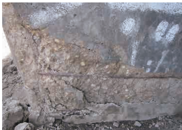
老朽化によるコンクリート剥離 (Meet Ghamr Br.) East Delta DO
