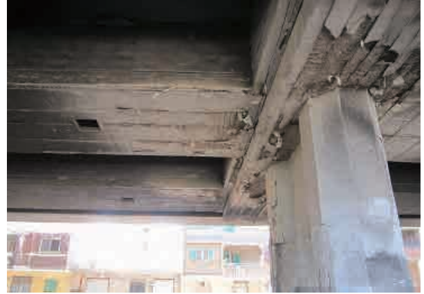
火災している橋脚 (Gd Section Br.)
