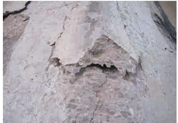
火災によるコンクリート剥離 (Gd Section Br.)
