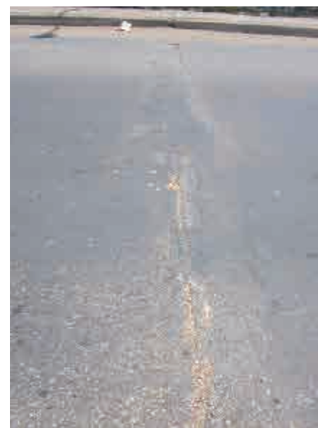
損傷した伸縮装置 (Meet Ghamr Br.)
