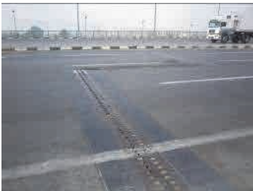
同一方向の車線上であるが、橋脚位置をずらした（橋梁下から見たが橋脚位置をずらす必要があったかは不明）ことにより路面に縦目地が発生しているが、ジョイントは特に設置されていない。
