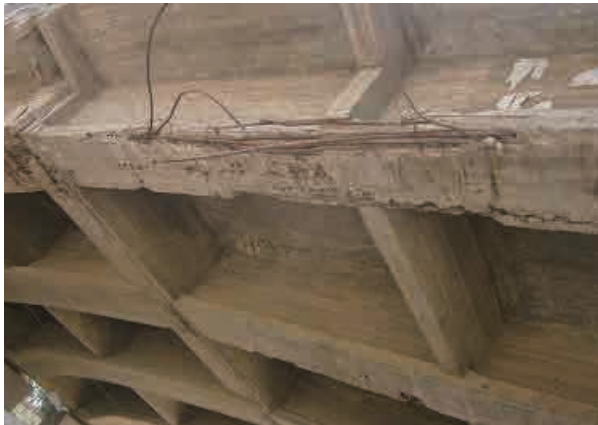
桁下不足による損傷 (Janakleez Br.) No.13 DO
