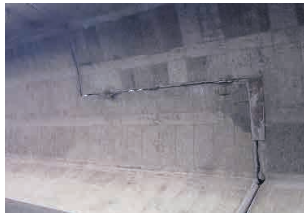
縦目地 (Al Warag Br.) コンクリート床版は縦目地があるが伸縮装置のようなものは何もない。隙間は漏水、遊離石灰が発生している。
