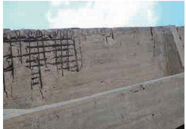
老朽化による鉄筋露出 (Janakleez Br.)
