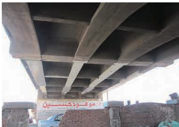
補修された RC 桁 (Meet Ghamr Br.) East Delta DO
