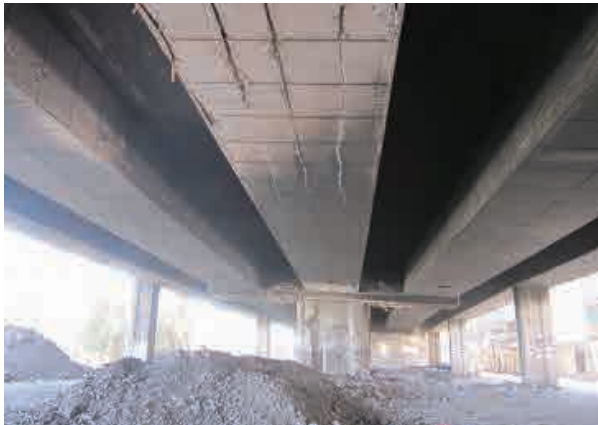
火災による上部工損傷 (Gd Section Br.)
