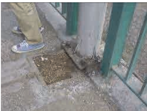
道路照明の基礎部分が施工不良（下に基礎部分のコンクリートがない）により、しっかり固定されていない箇所が多数発見された。
