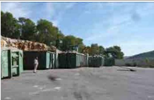
写真-5 トウルカレム中継基地1：中継基地のコンパクションユニットにて圧縮され、ジェニンの最終処分場にて処分される。
