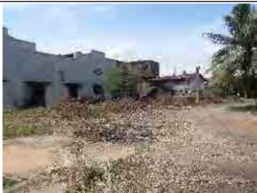
写真-5 新規浄水場の建設予定地(バタンバン)
