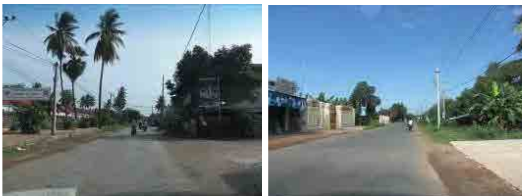
写真 3.2.2.6-1 一般的な管路布設予定位置の現況
