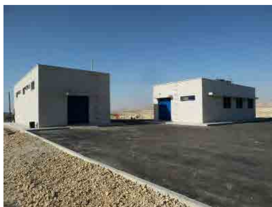
太陽光発電管理棟
