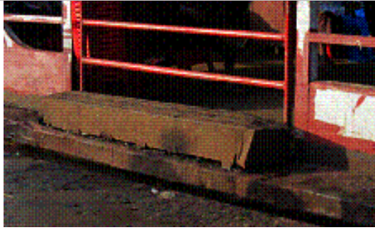
舷門部ステップの腐食
