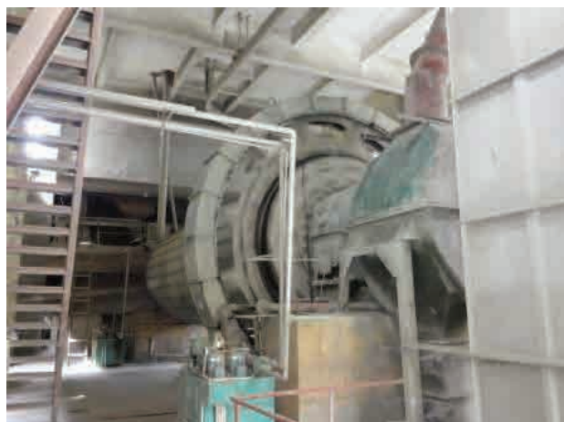
タエット・セメント工場の状況（2012年11月撮影）
