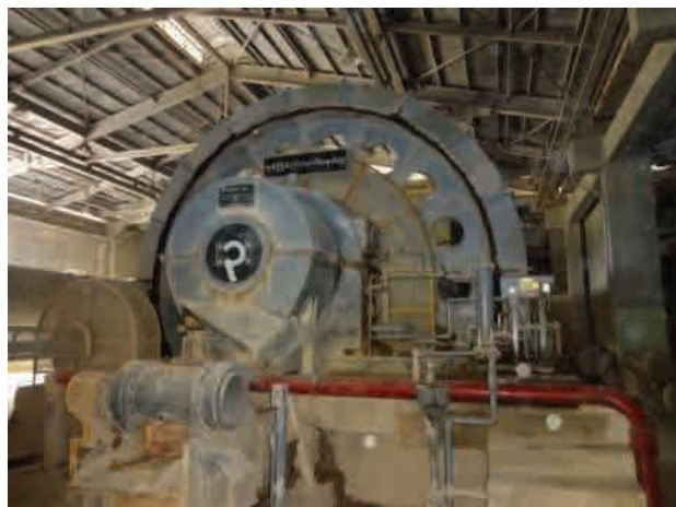
チャンギン・セメント工場の状況（2012年11月撮影）
