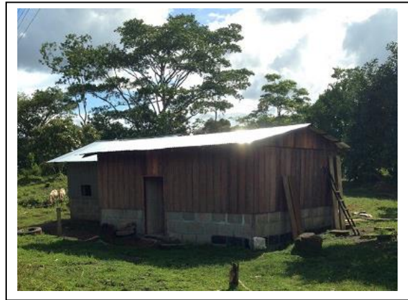
医療施設（保健の家） 地域住民が主導して保健施設を建設
