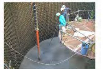
図 5 コンクリート打設 ㉔
