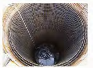
図 4 主鉄筋の組み立て ㉓
