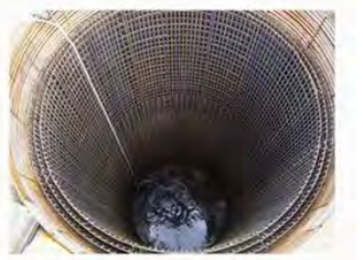
図 4 主鉄筋の組み立て ㉓
