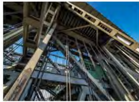
建設用リフトの安全 その4。使用の資格... itetama.jp
