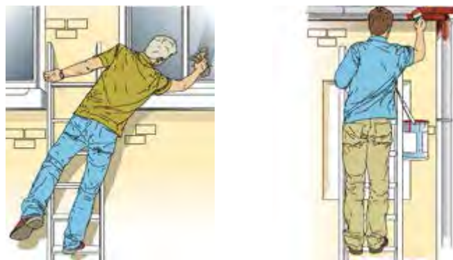
図1a 誤・3点指示をせず、ハシゴからはみ出している作業 図1b 正・3点指示をしている作業者
