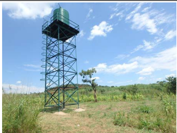
深井戸・高架水槽 計画敷地内には既存の深井戸・高架水槽があり、既存保健センターに給水している。本事業の計画施設にも利用予定。
