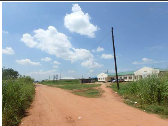
新ムシリ保健センター 前面道路 幹線道路からは、約300mの未舗装アクセス道路が続くため、ザンビア国側負担による舗装工事が予定されている。
