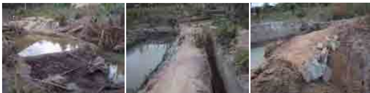
Công việc đào ao (tháng 2/ 2008)
