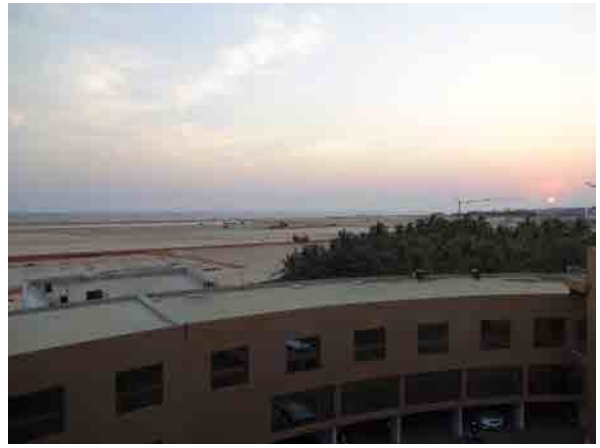
ロメ港湾公社よりロメ自治港西側の コンテナヤードの造成工事状況を臨む
