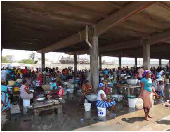
ロメ漁港、荷捌施設
