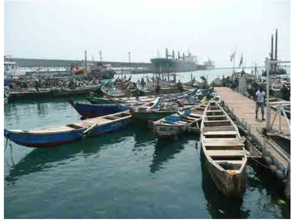
ロメ港湾公社によって設置された浮き栈橋 後方は鉱石の積み降ろし岸壁
