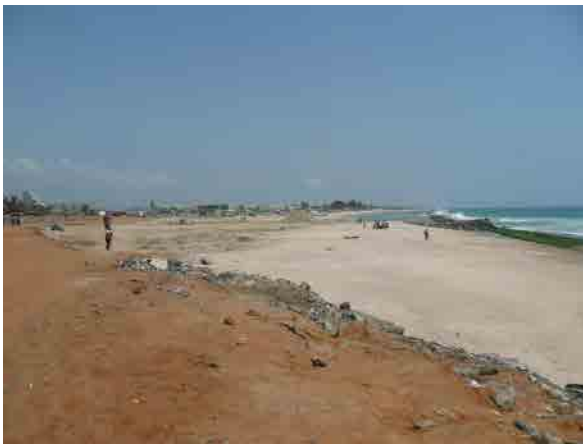
ロメ自治港東堤防外側付け根、右に見えるのがビーチ ロックで、既にサンドフィルによる造成が開始
