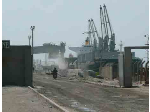
ロメ自治港東堤防の鉱石岸壁における粉塵
