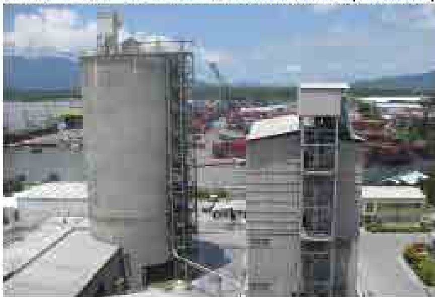
セメントサイロ、セメント粉砕ミル建屋(Cement Silo, Cement millbuilding)
