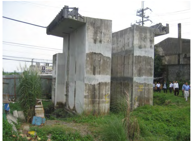
図 3-2 未完成の下部工（Guiguinto 付近）および放置された下部工（Caloocan 付近）
