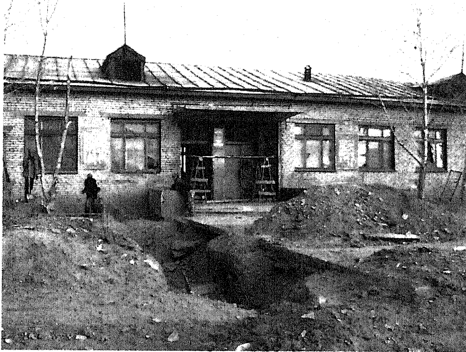
アイラグ学校工事現場（外観）
