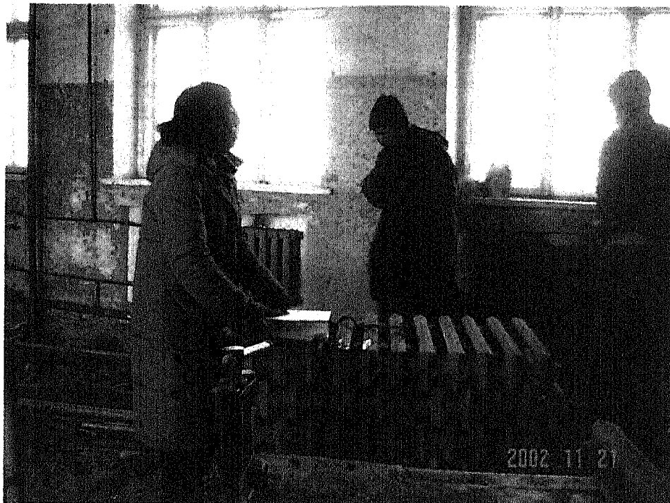
アイラグ学校工事現場（内部） （左が仲西隊員、中心が西村団員）
