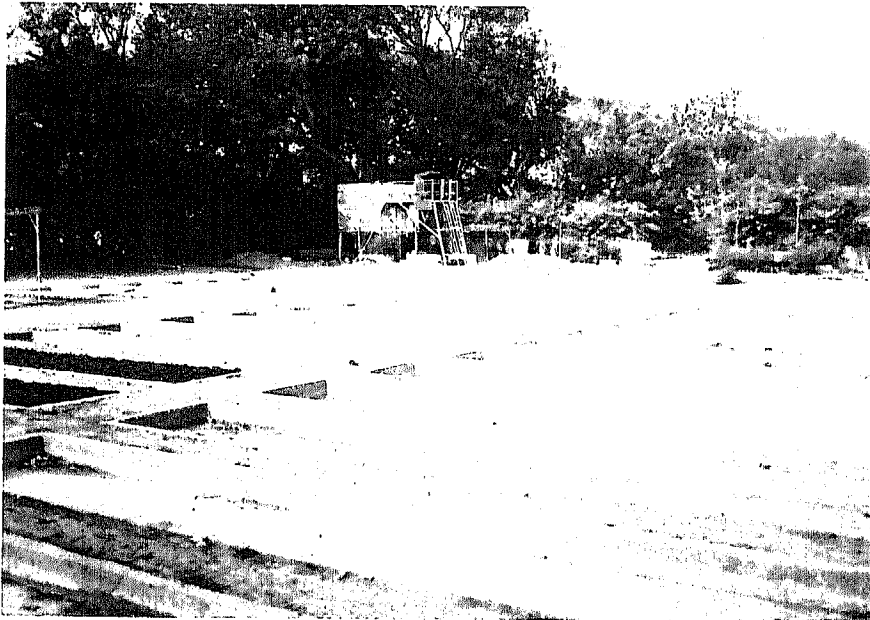
PHOTO 2 Piscine en béton Chateau d'eau (en arrière).
