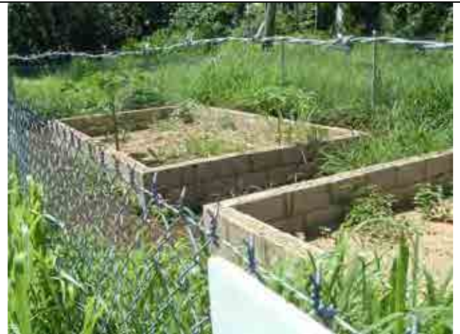
GEF の支援で (IWRM-VAVA'U 2010 プロジェクト)、ババウ処分場の隣に設置された下水汚泥の処理場。まだ使用されていない。IWRM : Integrated Water Resources Management.
