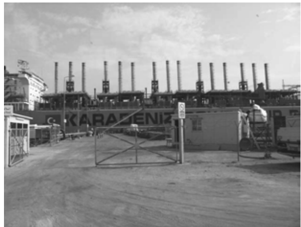
写真 3.3.25 12 バースの発電用バージ、 浚渫船
