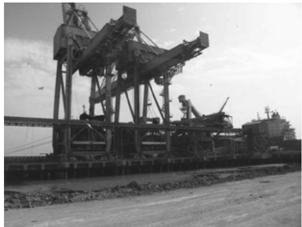
写真 3.3.27 11 番バースの離隔型棧橋
