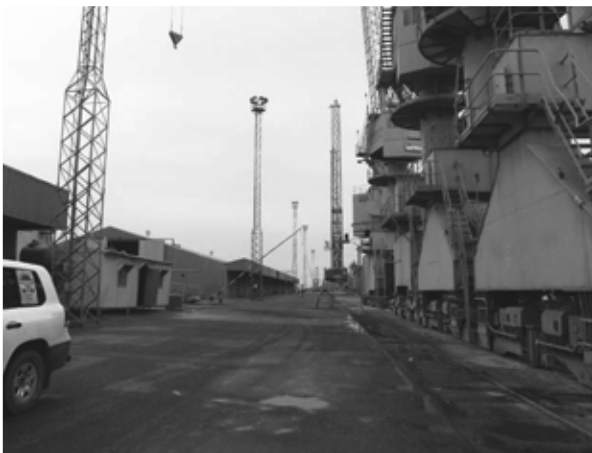
写真 3.3.6 7番バースの非稼働となったクレーン
