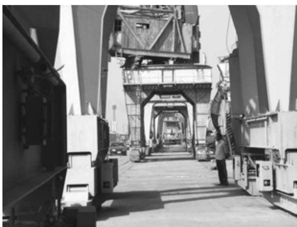
写真 3.3.54 稼働していない岸壁クレーン
