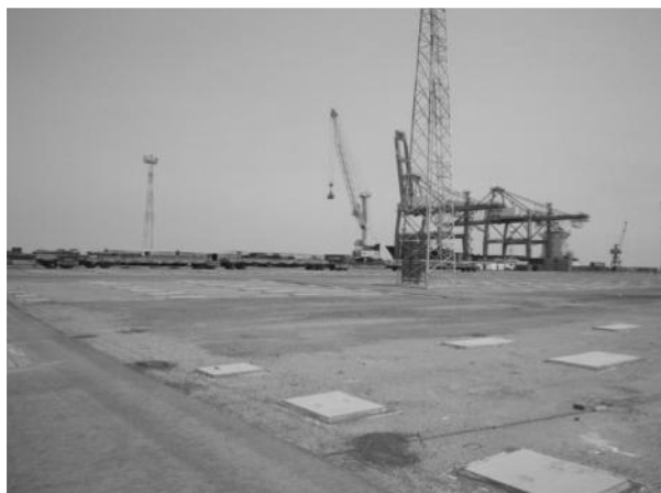
写真 3.3.21 21 番バース背後のコンテナヤード
