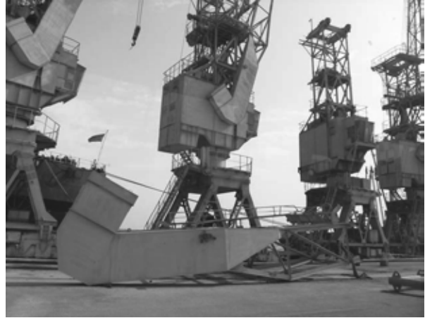
写真 3.3.29 非稼働の岸壁クレーン
