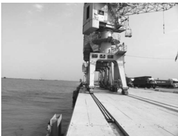
写真 3.3.48 2番バースの岸壁クレーンと防舷材
