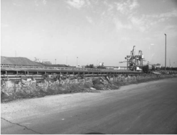
写真 3.3.28 10-11 番バース背後のヤード
