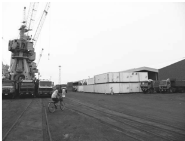
写真 3.3.20 12 番バースでの貨物荷役状況
