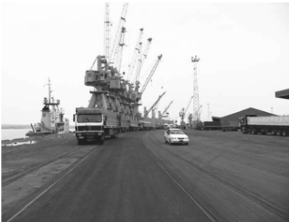
写真 3.3.16 20 番バースの岸壁用クレーン
