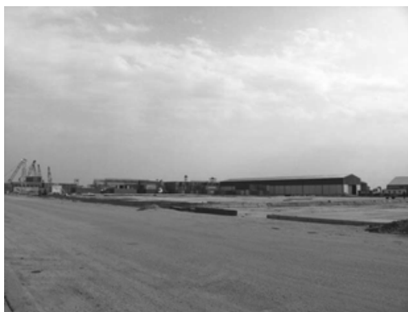
写真 3.3.51 建設中のコンテナヤード
