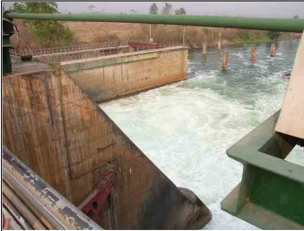
モビエダム発電用取水状況
