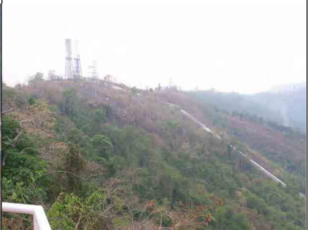
バルーチャン第二水力発電所
