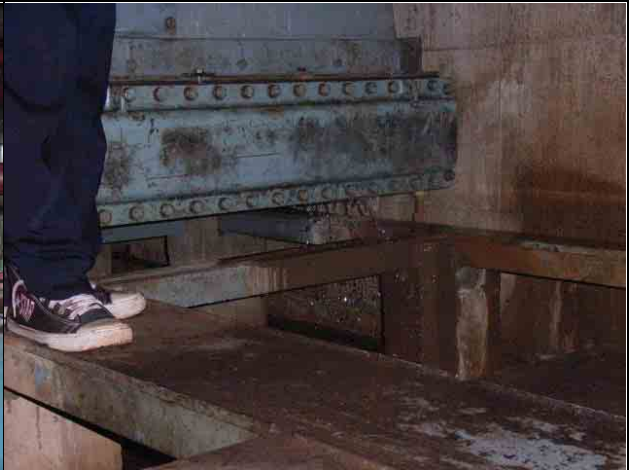
4号発電機冷却器漏水(追加要請)
