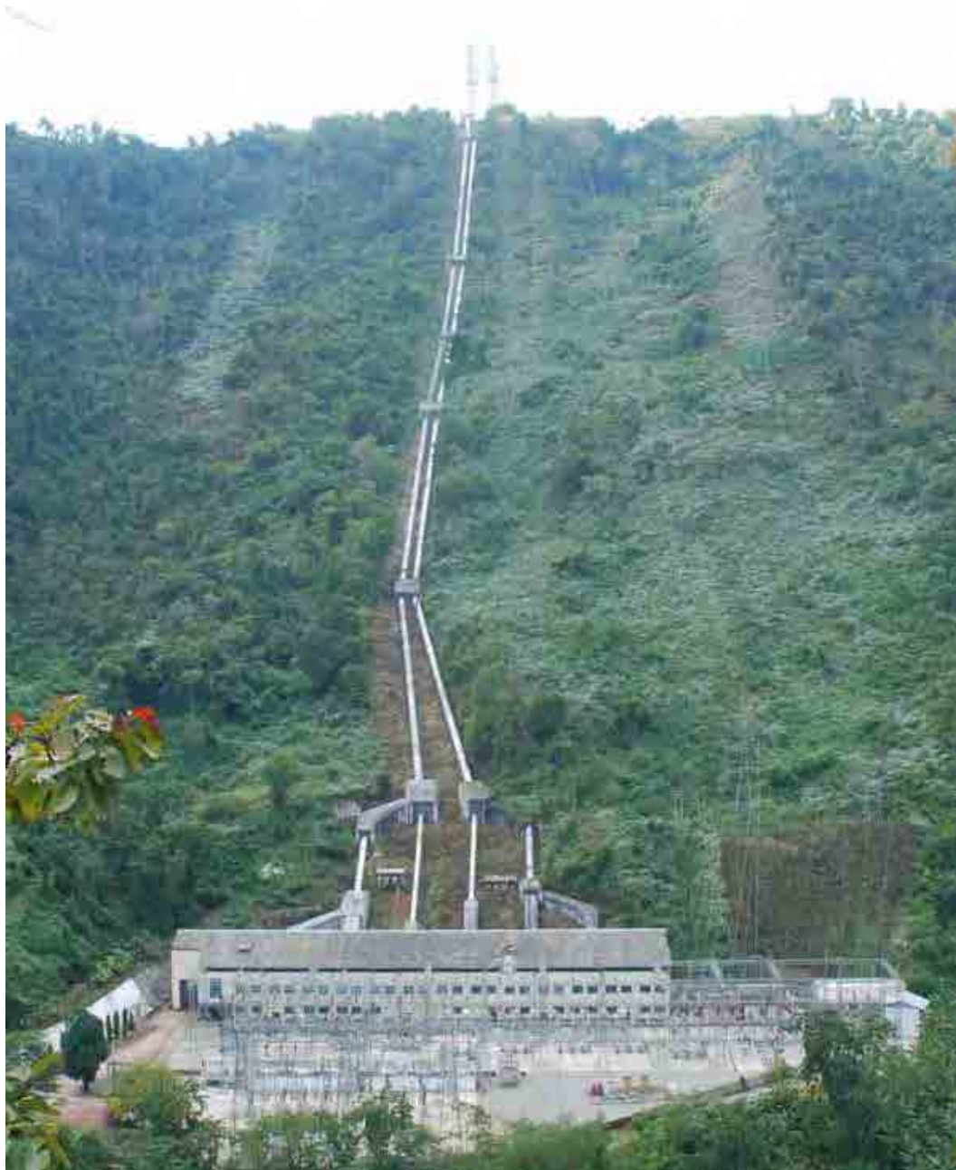
パルーチャン第二水力発電所全景
