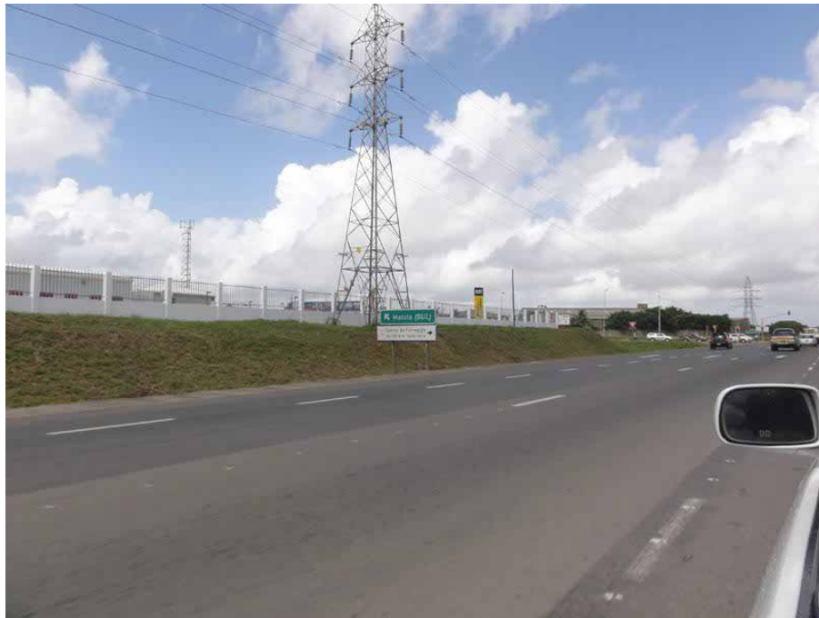
図4.5-3 EN2号線（片側2車線）
