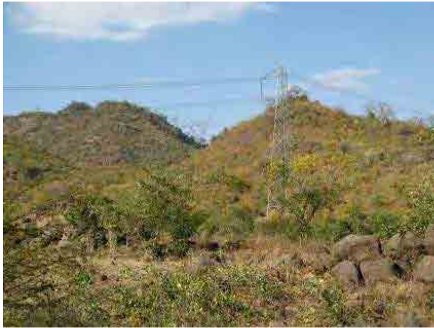
図3.3-11 南ア向け直流±535kV送電線（手前）と Matambo変電所向け交流220kV送電線（奥）
