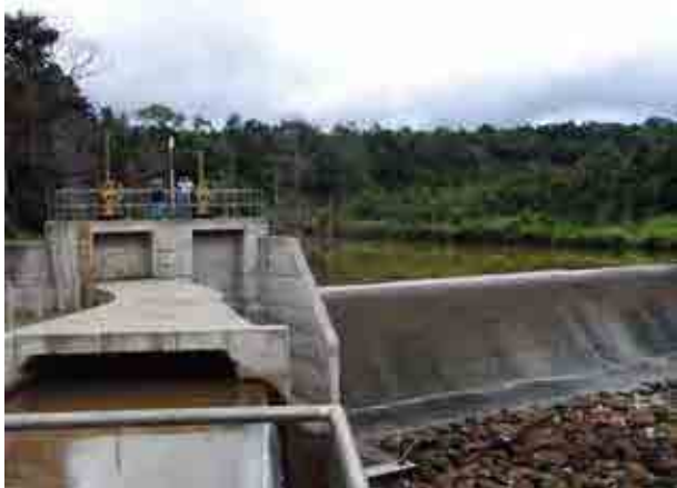
1. 小水力発電施設
