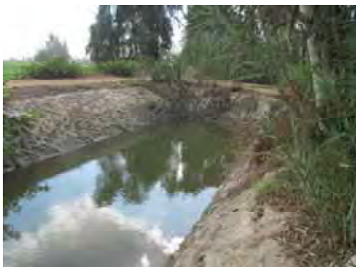
共同補修工事後の水路 (Kafr El Sheikh)
