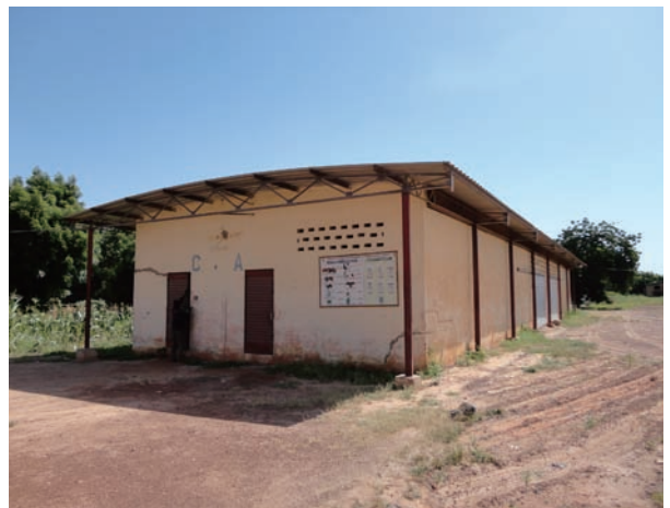
写真⑫ CAIMA 肥料保管倉庫（1,000MT の貯蔵量） （ドッソ州）
