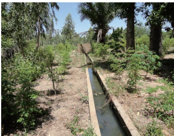
⑰写真 深井戸利用による用水路施設状況 (FAO 技術支援による) (ドゥソ州)
