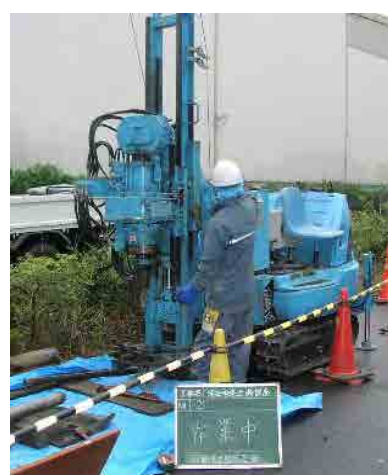
ボーリングマシンによる試料採取
