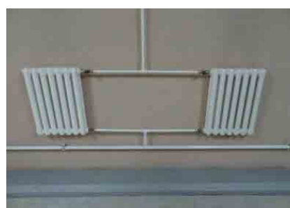
図-4-2-3 暖房用ラジエーターの例
