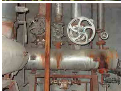
図-4-1-3 各蒸気ヘッダーのサーモ写真と通常写真
