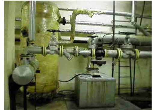
図-5-8: 飼料工場ドレンセパレーター
