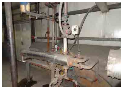
図-4-2-2 給湯用温水熱交換器
