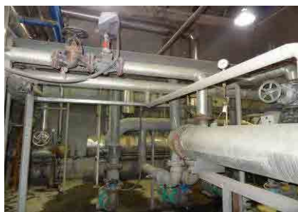
図-4-2-1 暖房用温水熱交換器
