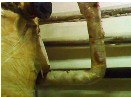
図-5-4-1: 飼料工場ドレンセパレーター入口ノズル廻り
