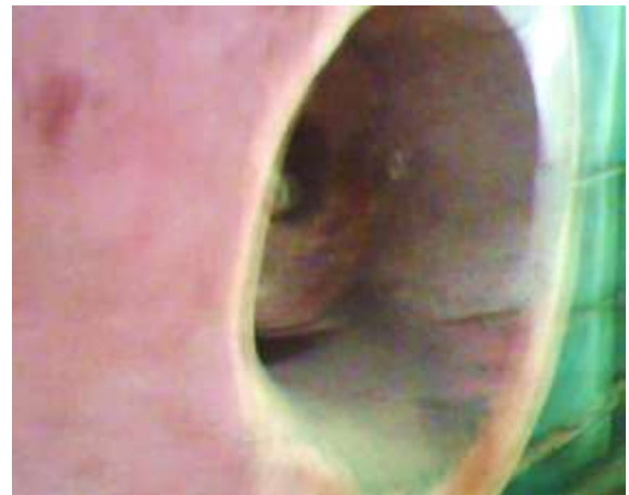
写真-6-2：スチームドラムマンホール廻り 通常写真
