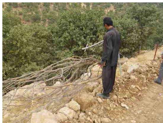
フェンス改良工事 (現状調査)
