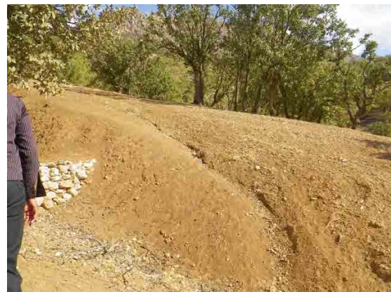
チェックダム維持管理 (小規模ガリへの補強)
