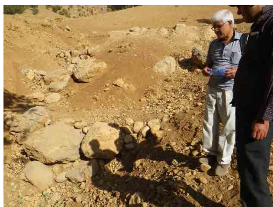
チェックダム維持管理 (エプロンの補修の指示)
