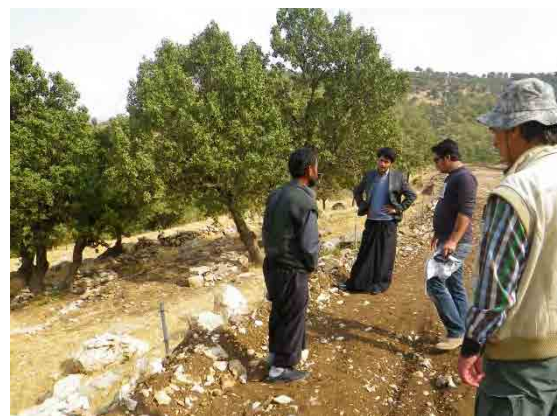
フェンス改良工事 (対策の検討)
