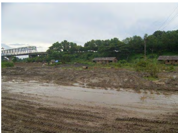
道路建設ユニット No.9 の敷地
