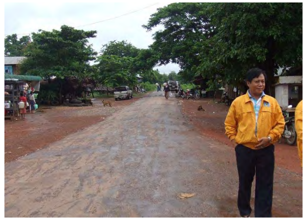
パイロット工事予定箇所
