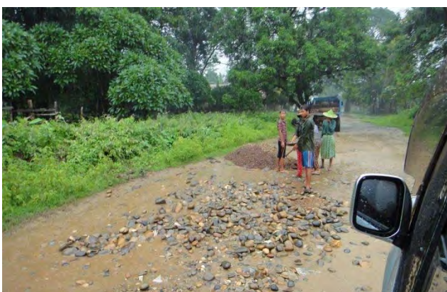
地域住民を雇用した対象道路の補修作業
